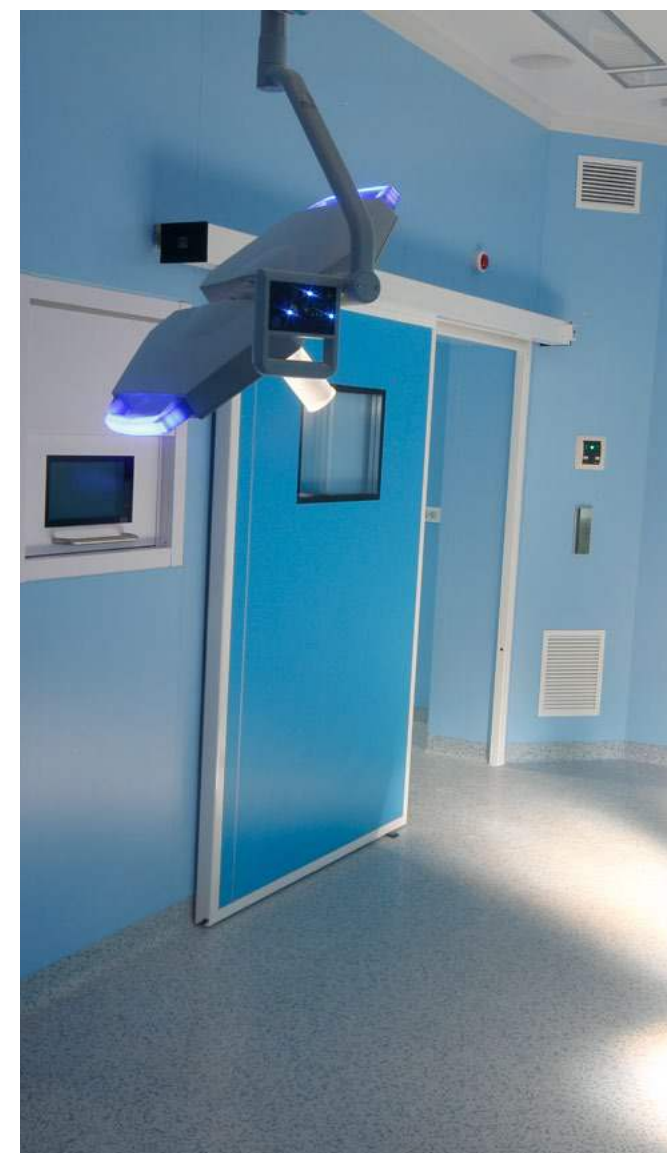
Ușă etanș ermetică, Bloc operator
