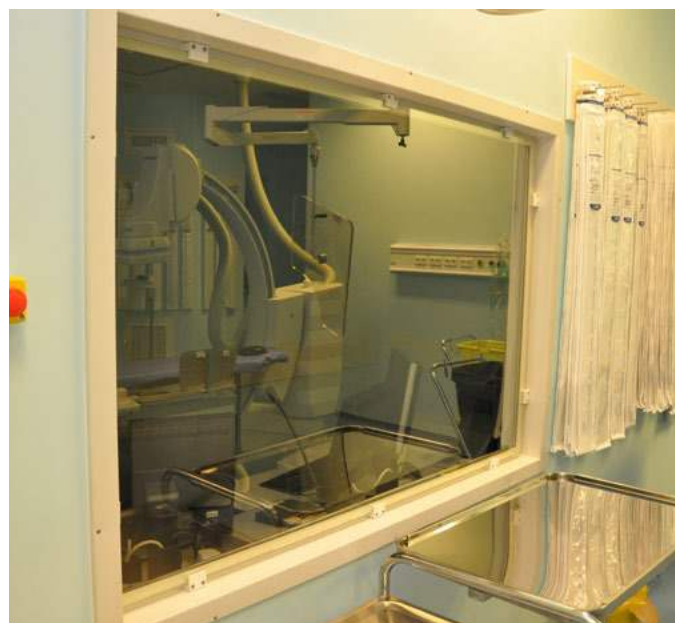
Vitraj cu protecție la radiații, Laborator radiologie
