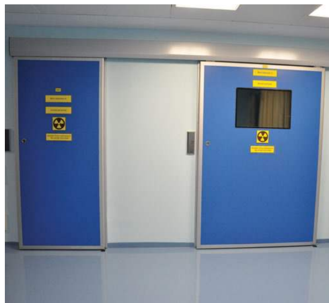
Uși automate cu inserție de plumb, Bloc operator
